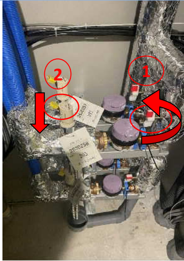
①(赤)を閉めてから②(黄)のレバーを下 げます。①②の順番で操作して下さい。
