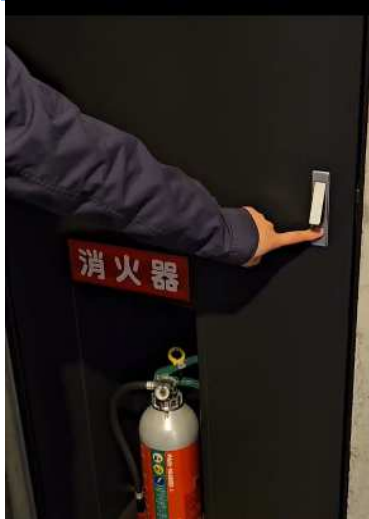
パイプシャフトを開けます。
